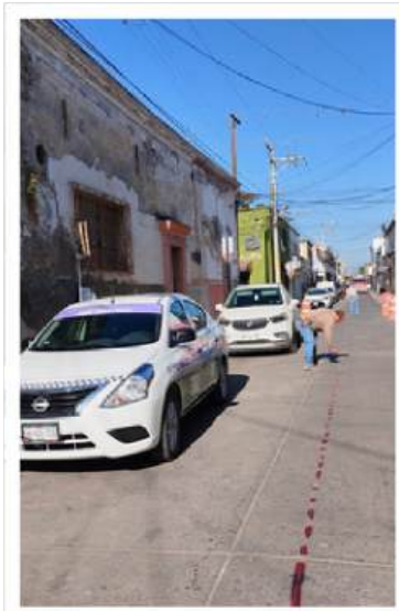
Rehabilitación de drenaje sanitario en calle Gallardo de calle Madero a calle Hidalgo.
