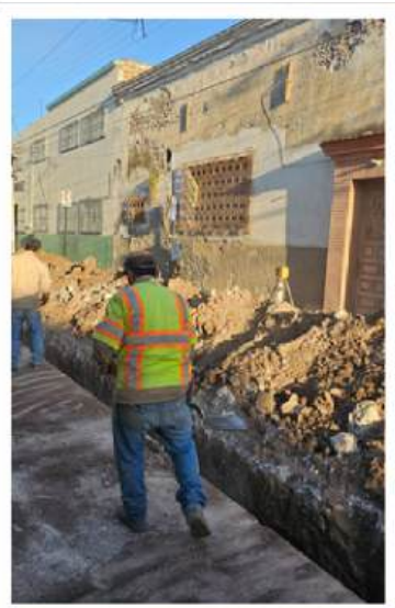
Rehabilitación de drenaje sanitario en calle Verástegui en calle San Miguel a calle Insurgentes.
