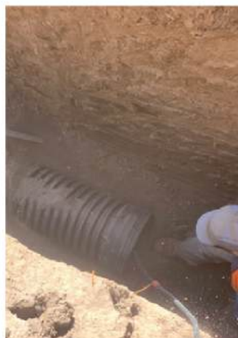
Construcción de drenaje sanitario en el sector oriente de Rioverde (ZAP 046A) en calles Verástegui, San Francisco de Asís y Noche Buena.
