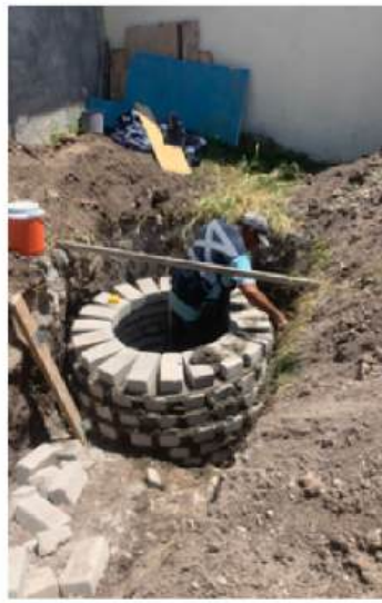
Construcción de drenaje sanitario en el sector oriente de Rioverde (ZAP 046A) en calles Verástegui, San Francisco de Asís y Noche Buena.
