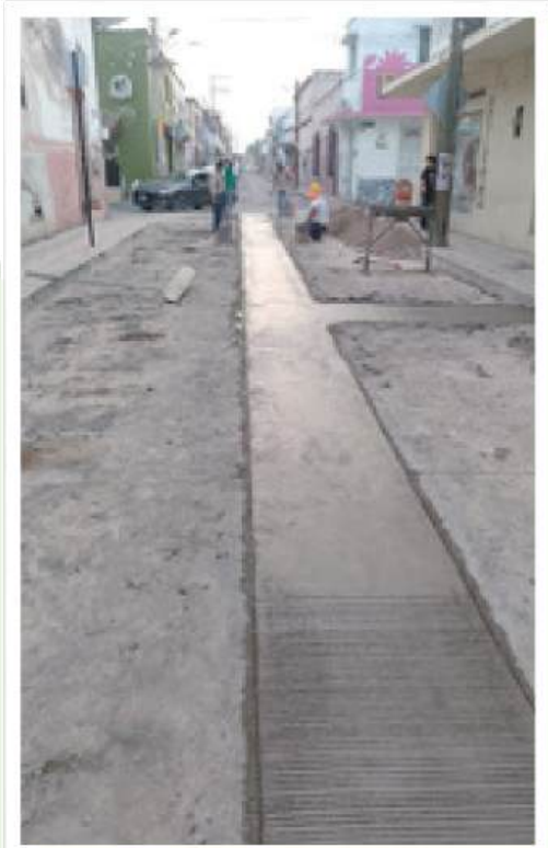
Rehabilitación de drenaje sanitario en calle Verástegui en calle San Miguel a calle Insurgentes.
