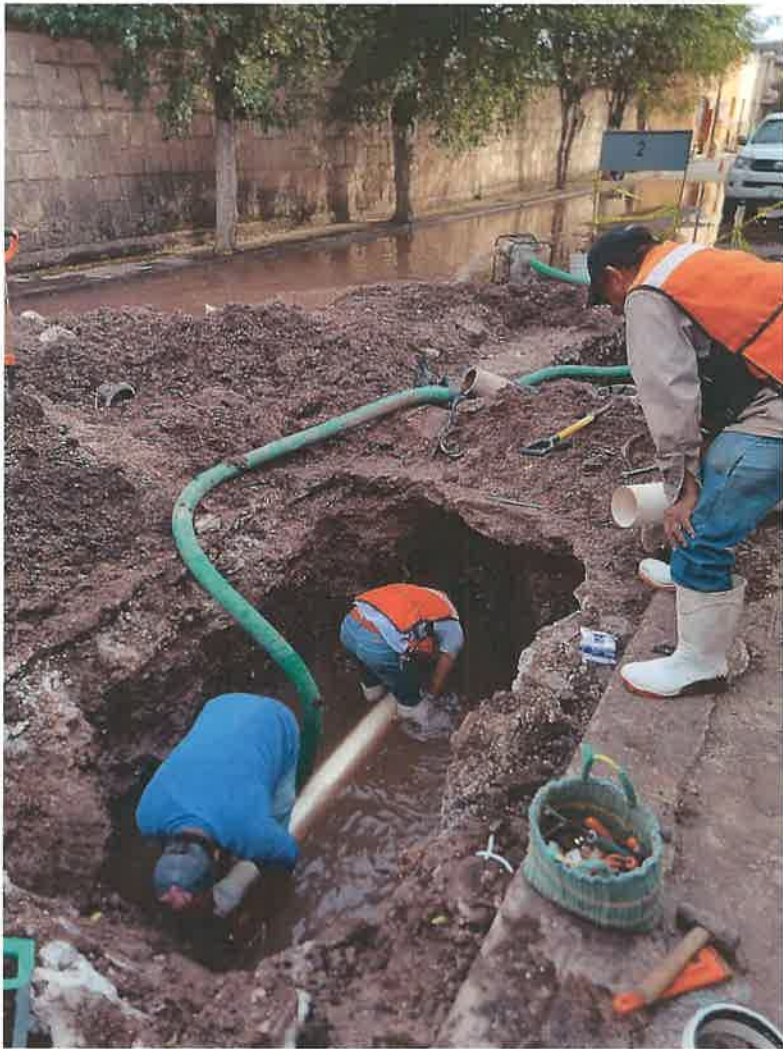
Reparación de Fuga en Ren de Distribución.
