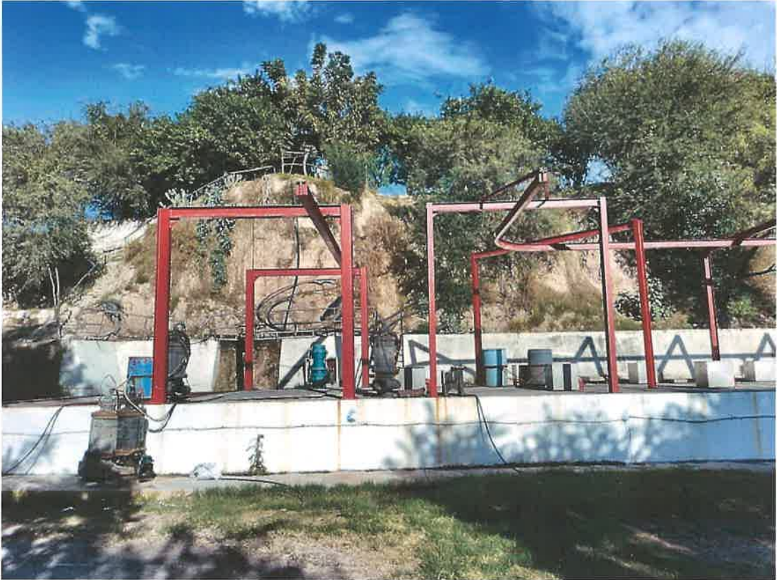
Instalaciones del Cárcamo de Bombeo.
