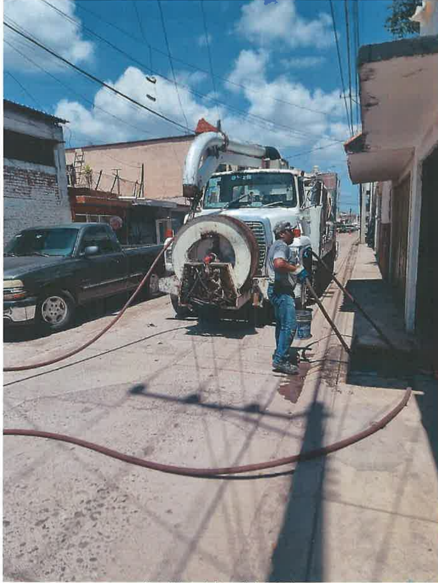
Mantenimiento de Alcantarillado Sanitario.
