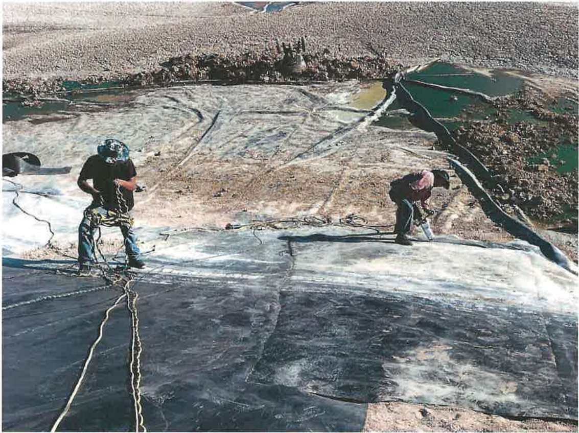
Reparación de Membrana en Sistema Lagunar.
