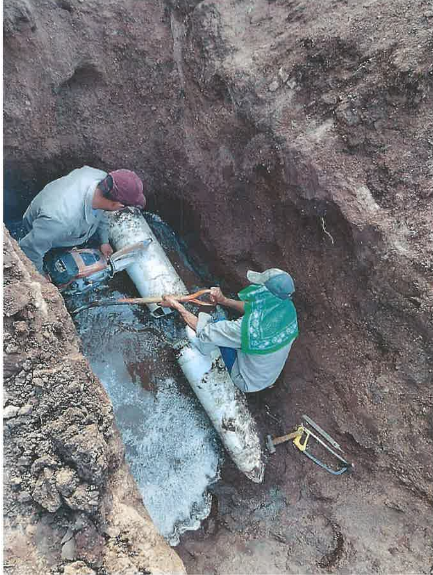
Reparación de Fuga en línea de conducción.
