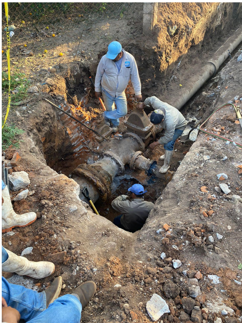
Sustitución Línea de Conducción, Zona de Pozos.
