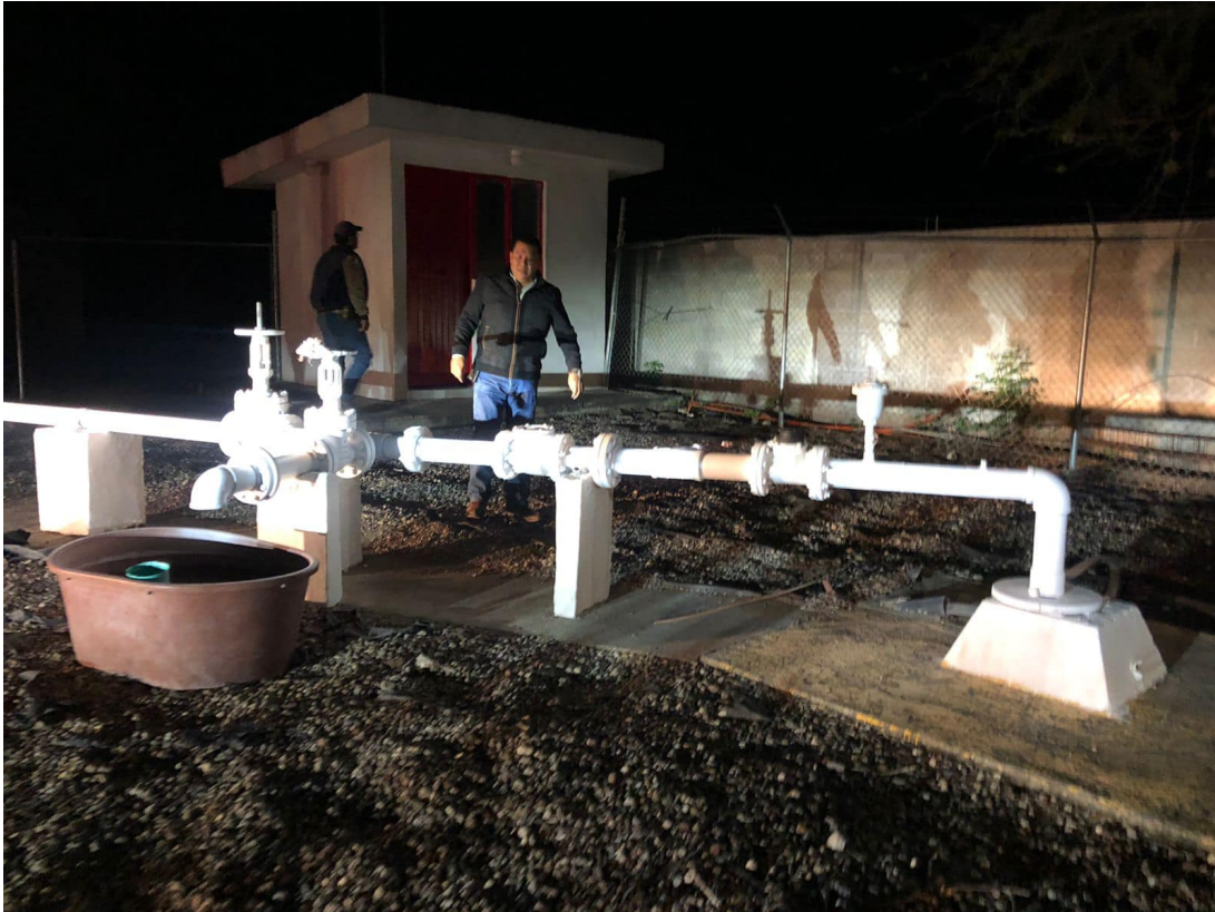
Revisión de instalaciones por parte del C. Presidente Municipal.
