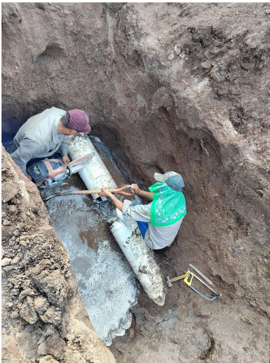
Reparación de Fuga en línea de conducción.
