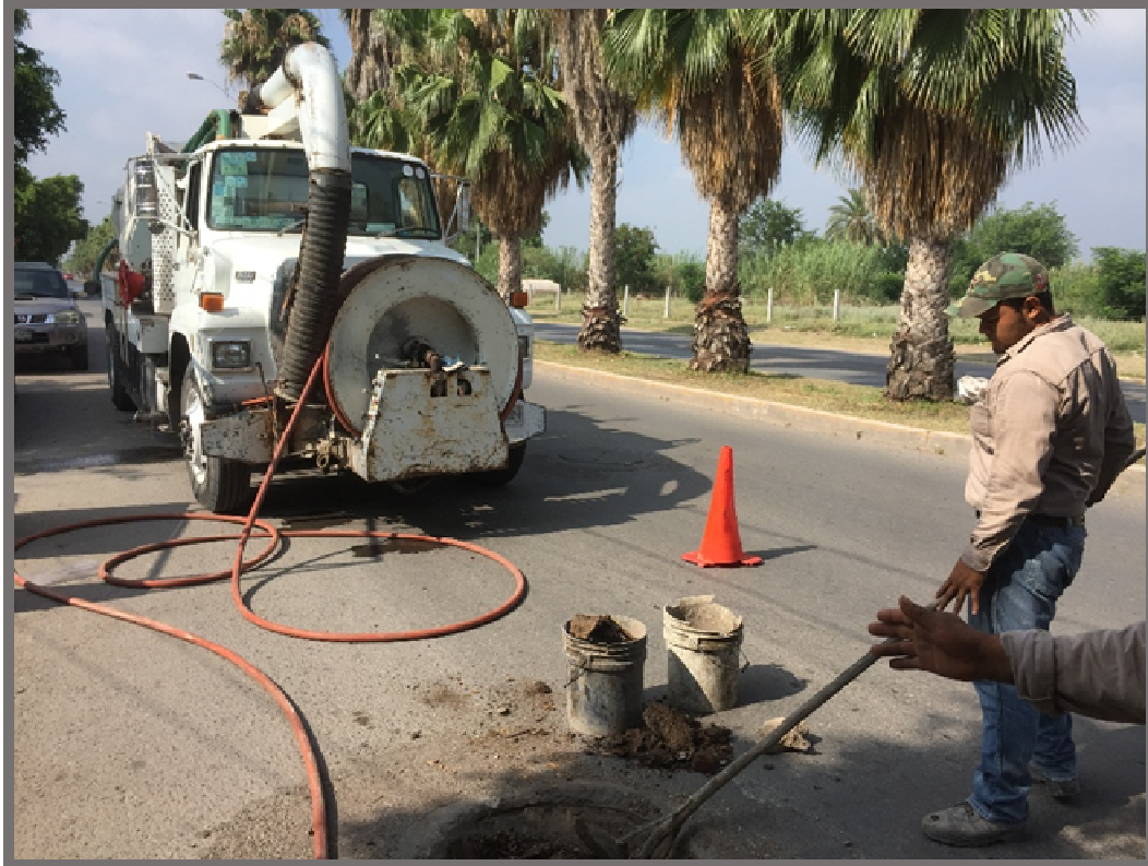
Mantenimiento de Alcantarillado Sanitario.
