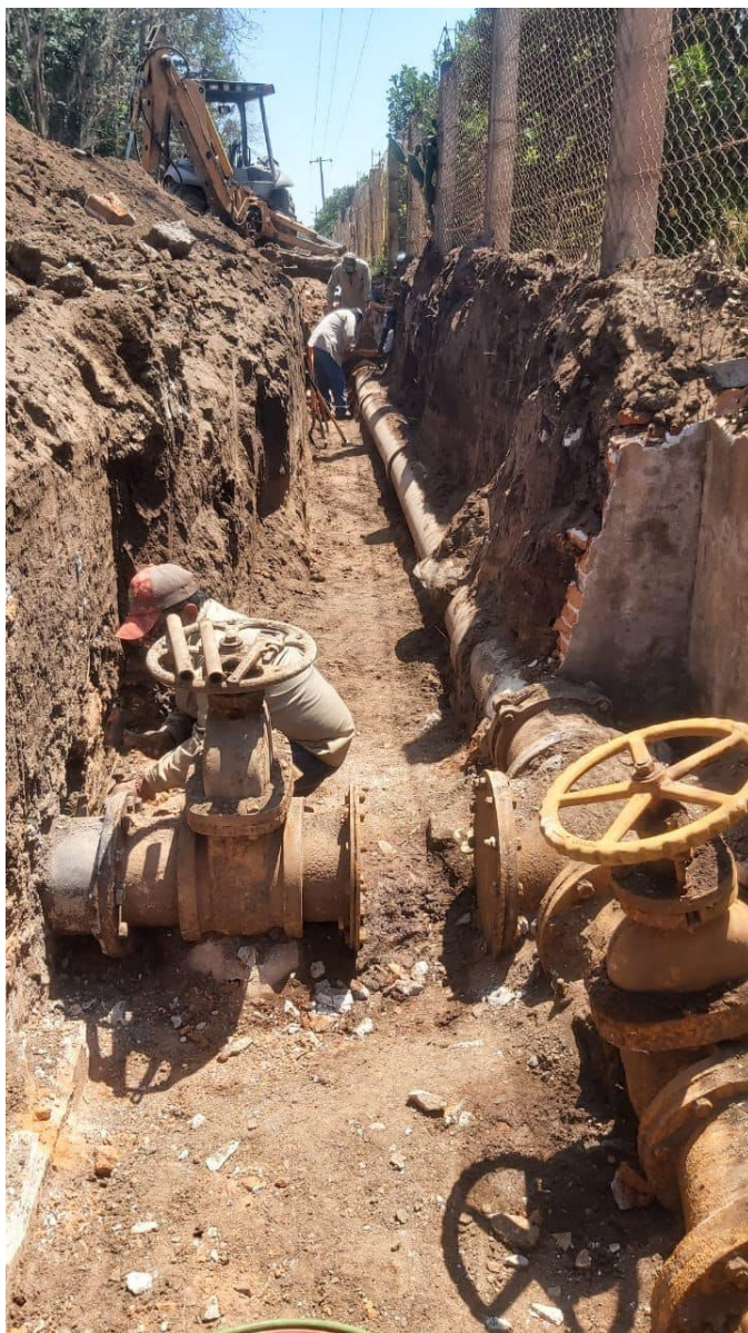
Reposición de infraestructura.
