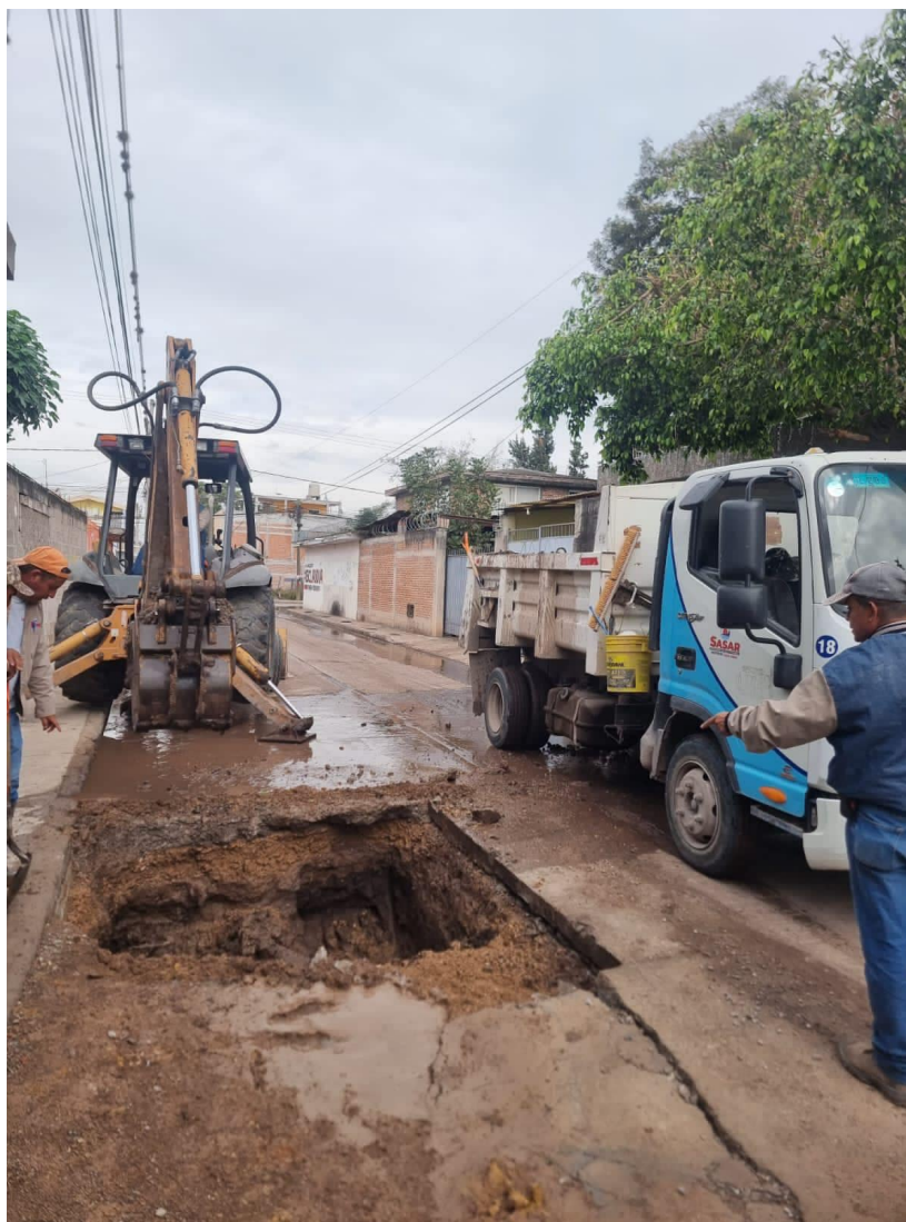
Reparación de Fugas.
