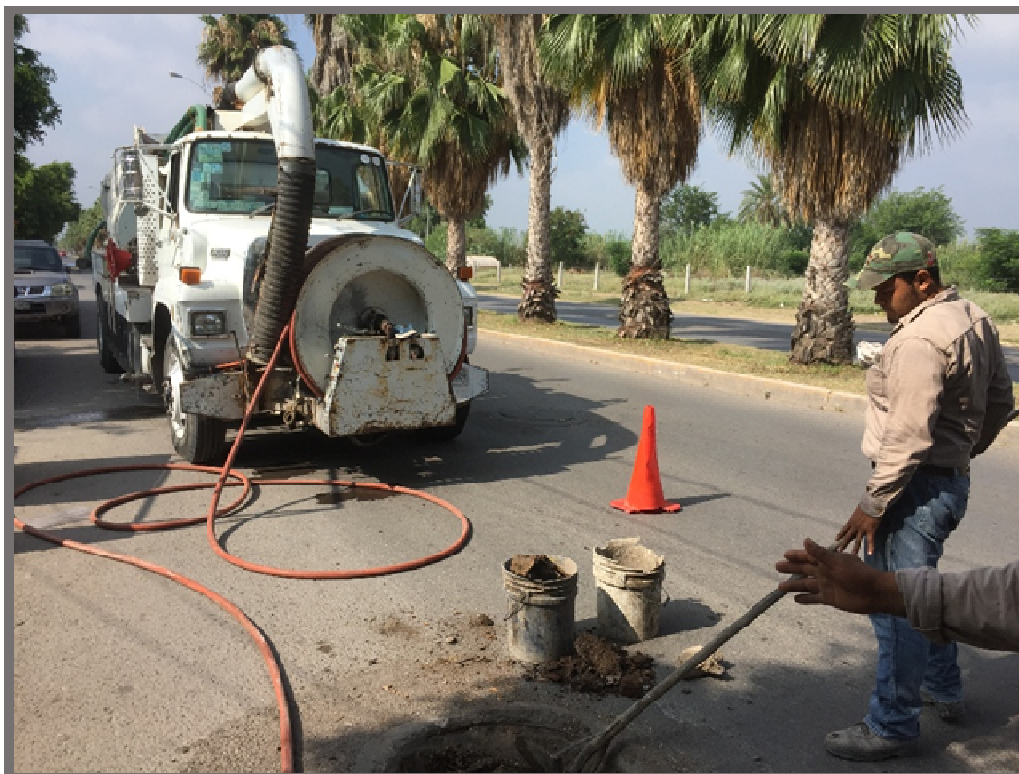
Mantenimiento de Alcantarillado Sanitario.
