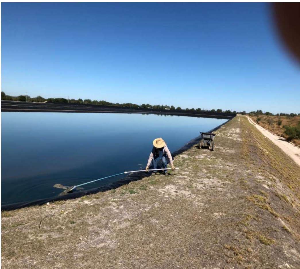
Planta de Tratamiento Riovere.
